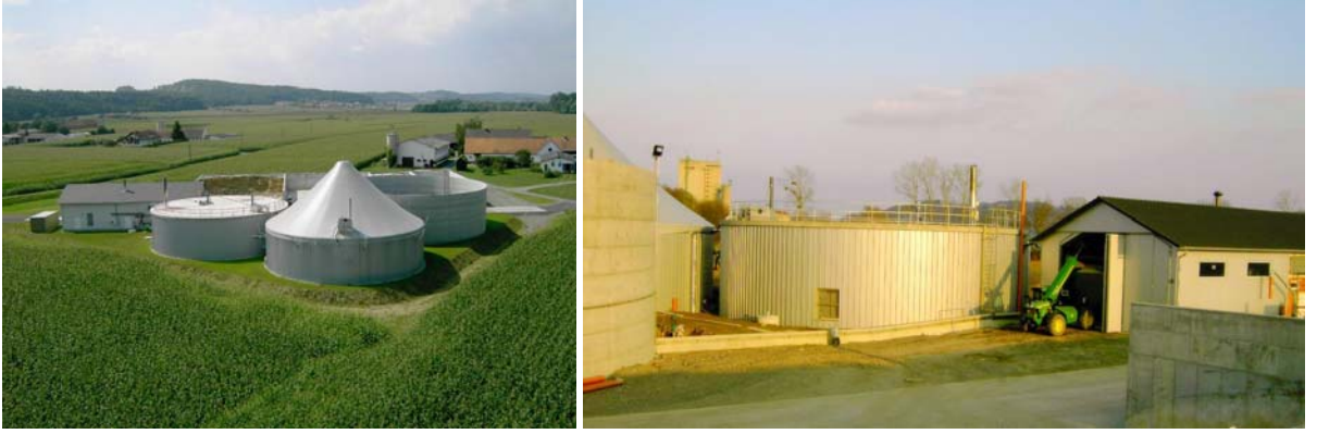
Şekil-2: Büyükbaş Hayvansal Atık Arıtım Biyogaz Tesisi Fotoğrafları (Güssing-Avusturya) (Tolay vd., 2008; www.aev-biogas.de).
